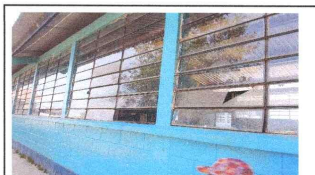
Foto 4: Sustitución de vidrios
