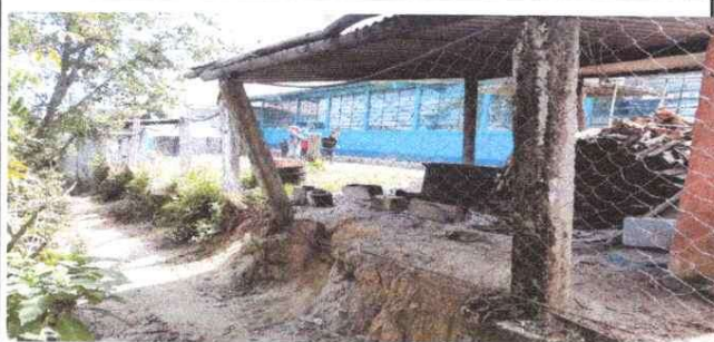
Foto 5: Sustitución de muro perimetral con tubo y malla
