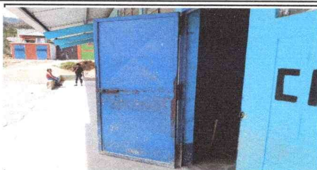
Foto 2: Sustitución de puertas de aulas
