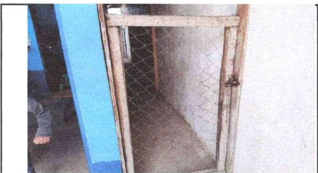
Foto 3: Sustitución de porton
