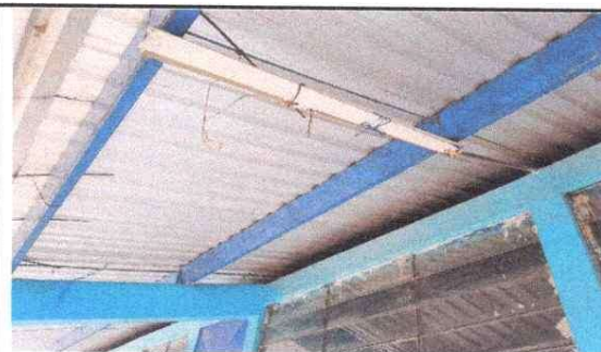
Foto 6: Sustitucion de sistema electrico
