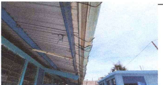
Foto 6: Sustitución de canales
