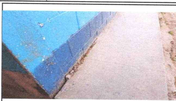
Foto 2: Sustitución de pintura exterior
