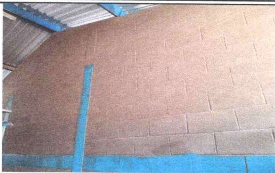
Foto1: sustitución de pintura interior
