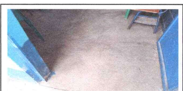
Foto 5: Sustitución de piso
