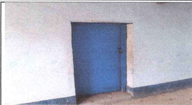
Foto 1: sustitución de puerta de madera por metal de cocina
