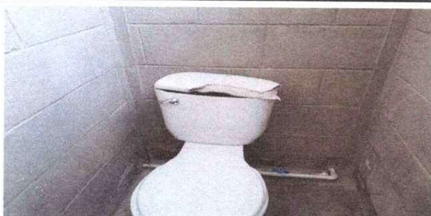
Foto 3: Sustitución de inodoro
